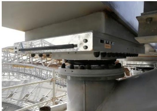
Łożysko TETRON® SB z ISOGLIDE® Stadion Al Bayt, Katar
