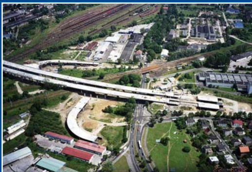
Wiadukt nad torami kolejowymi i ulicą Strzegomską we Wrocławiu
