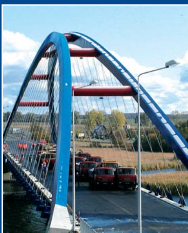
Most przez Dziwnę w ciągu obwodnicy Wolina
