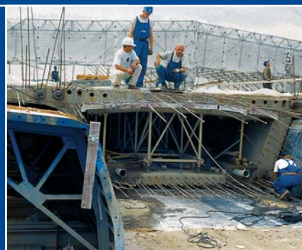
Węzeł Czerniakowska - wiadukt CE-1
