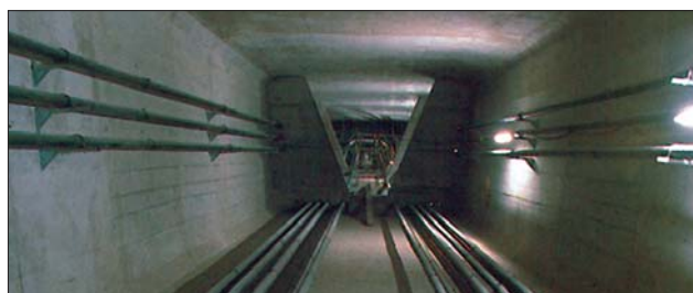
Kanały z polietylenu o dużej gęstości HDPE do sprężania zewnętrznego.
