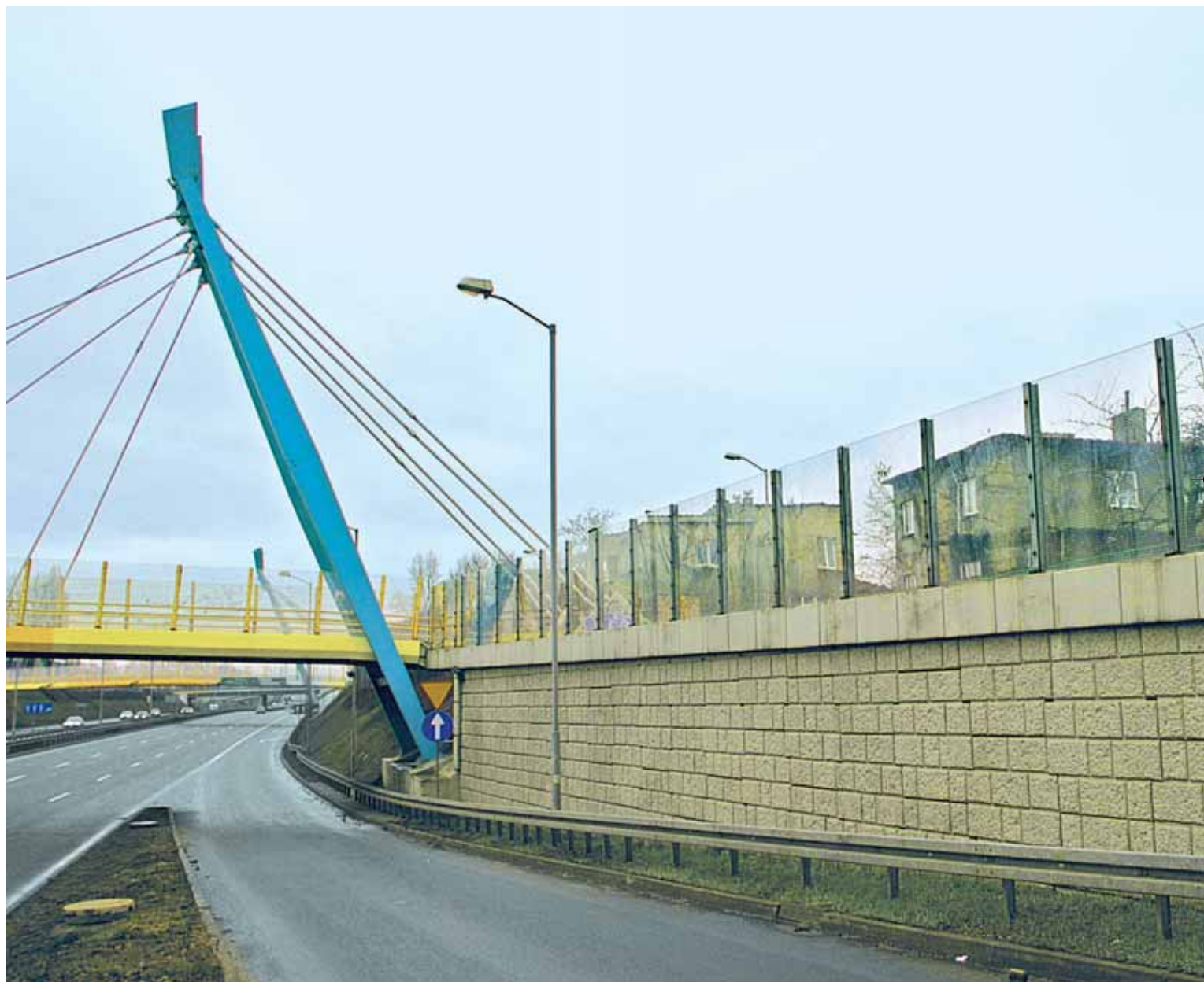
DTŚ Chorzów INWESTOR: DTŚ S.A., WYKONAWCA: PRInz S.A. Holding
