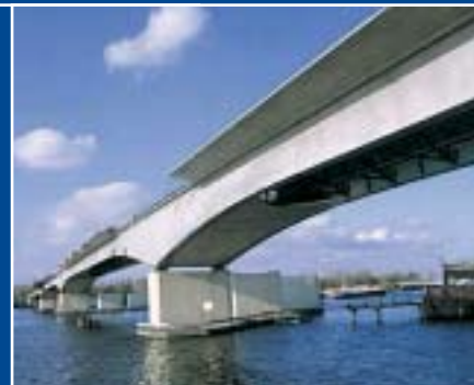
Most nad Regalicą w Szczecinie – dylatacje blokowe Multiflex i 3W
