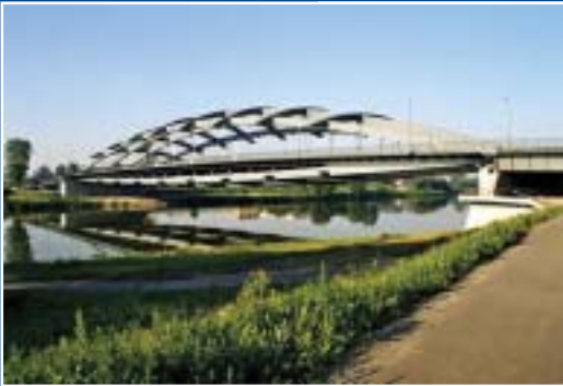
Most Kotlarski w Krakowie – dylatacje blokowe Multiflex
