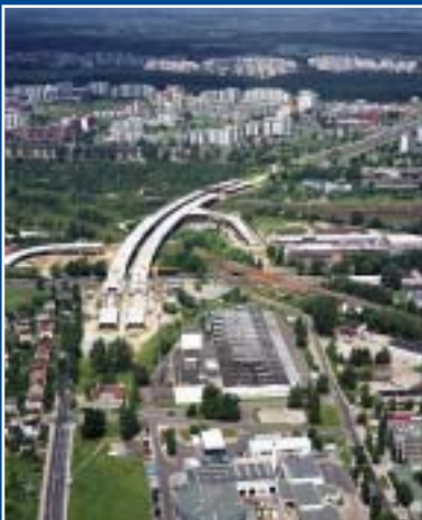
Wiadukt nad torami kolejowymi i ulicą Strzegomską we Wrocławiu – dylatacje Multiflex oraz 3W
